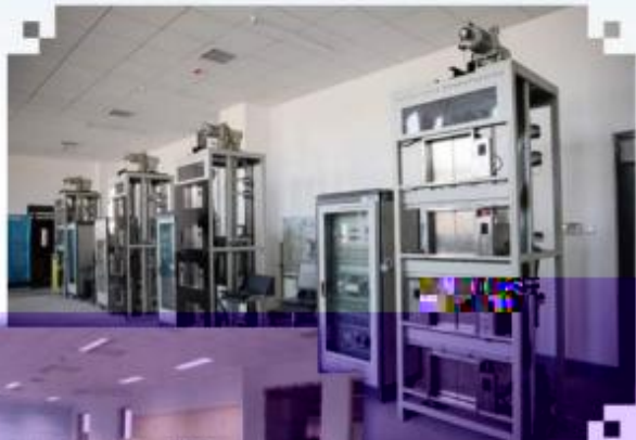
智能电梯安装调试 维护训练场所
